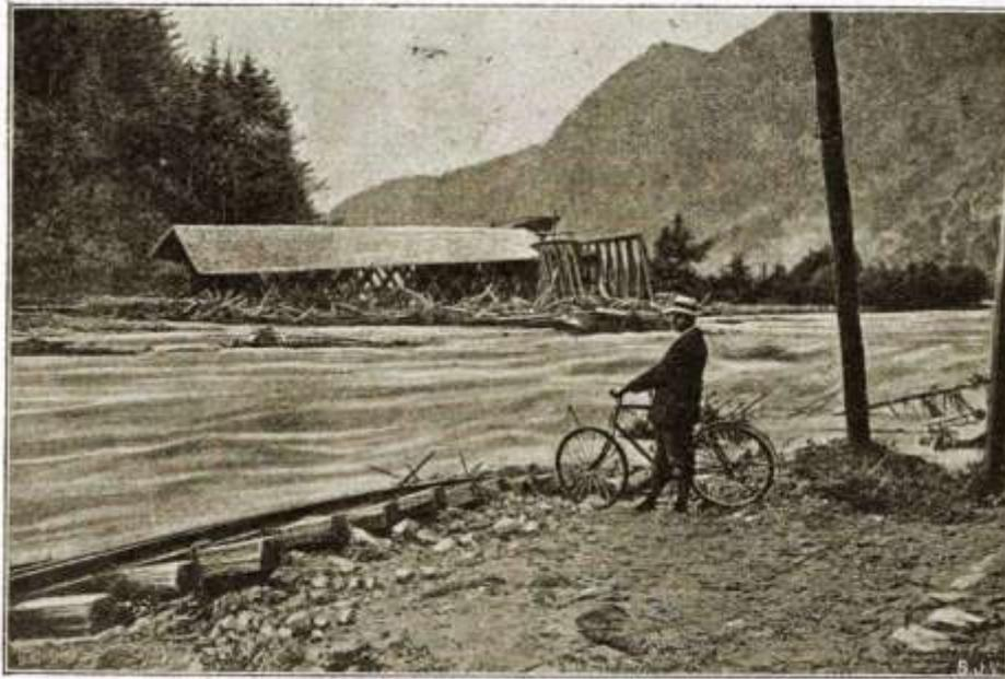
Die durch die Gewalt des Wassers fortgerissene und gegen eine eiserne Brücke der Montafonerbahn getriebene hölzerne Illbrücke. – Im Vordergrund das zerstörte Geleise der Montafonerbahn.
